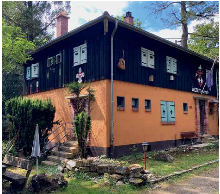
Pfadfinderheim auf der Hohen Eiche. Das Haus bietet den Gruppen Möglichkeiten für Heimabende, Zusammenkünfte, Übernachtungen und Lagerung von Material.
