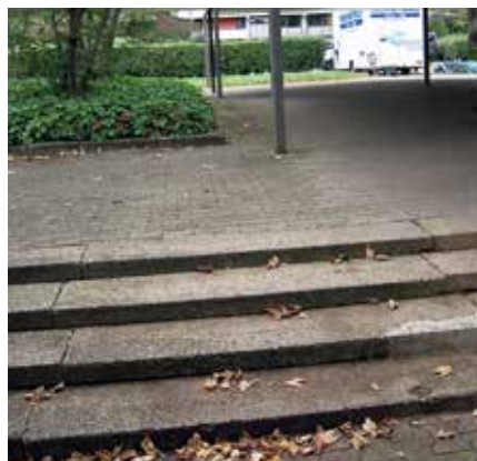
Die vier Stufen auf dem Weg vom Ladenzentrum in Richtung Gebäude C sind für den Rollator eine ernste, für den Rollstuhl eine unüberwindliche Barriere.
