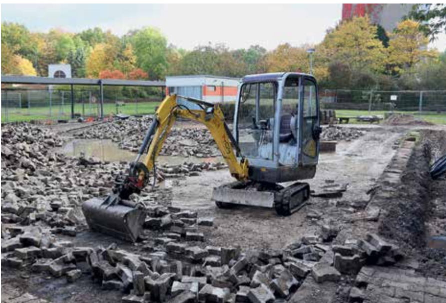
Der Brunnen war lange Zeit eine Baustelle. Seine Instandsetzung stellte sich als unerwartet schwierig heraus und dauerte weit über ein Jahr.
