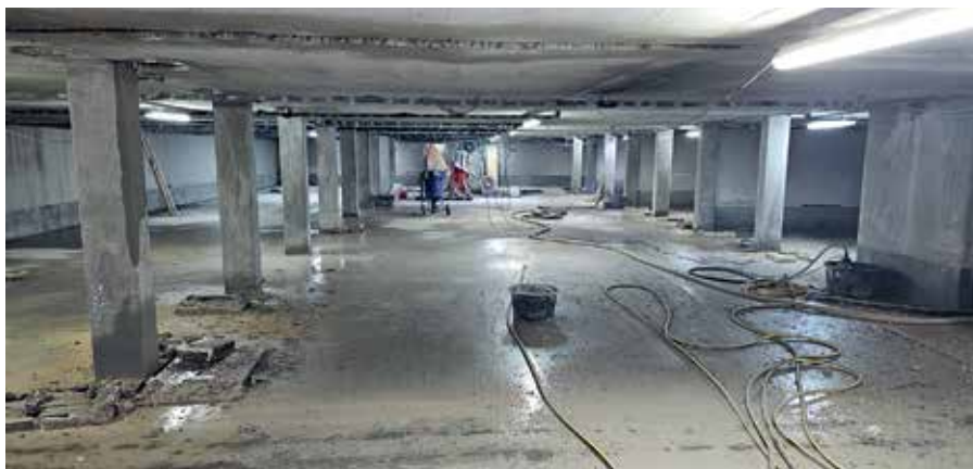
Teilabschnitt des Sanierungsbereiches in der Tiefgarage vor Gebäude B. Insgesamt sind 66 Stellplätze von den Arbeiten betroffen.
