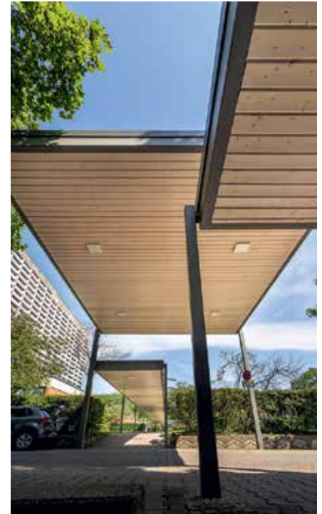
Die Höhenstaffelung der Pergola erzeugt abwechslungsreiche Sichtbezüge.
