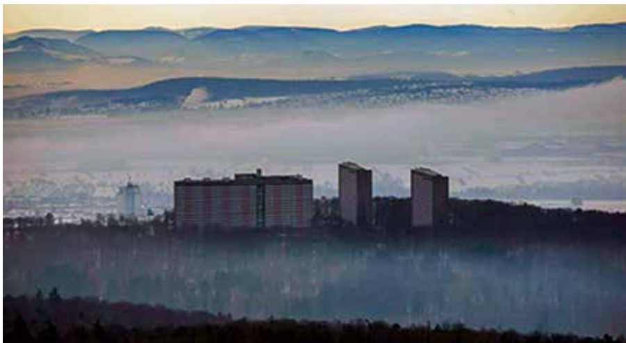
Bild 1: Luftaufnahme der Wohnstadt Asemwald
