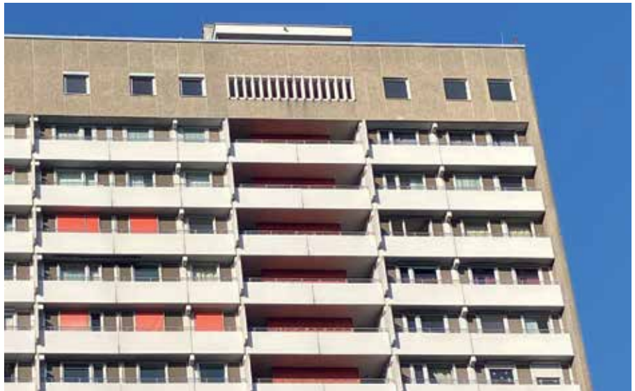
Bild 8: Gebäude C, Ostfassade oberste Geschosse
