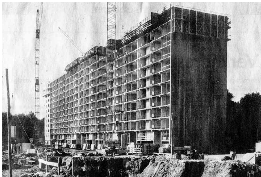
Bild 1: Gebäude B, Rohbau ohne Fassaden
