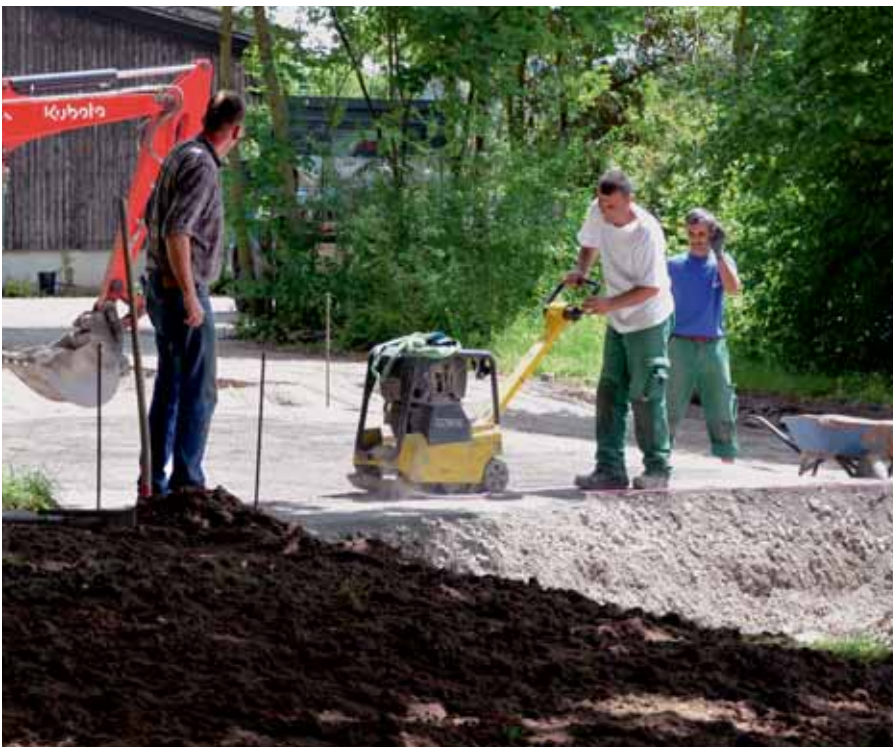
Beim Rückbau des ehemaligen Kompostplatzes.
