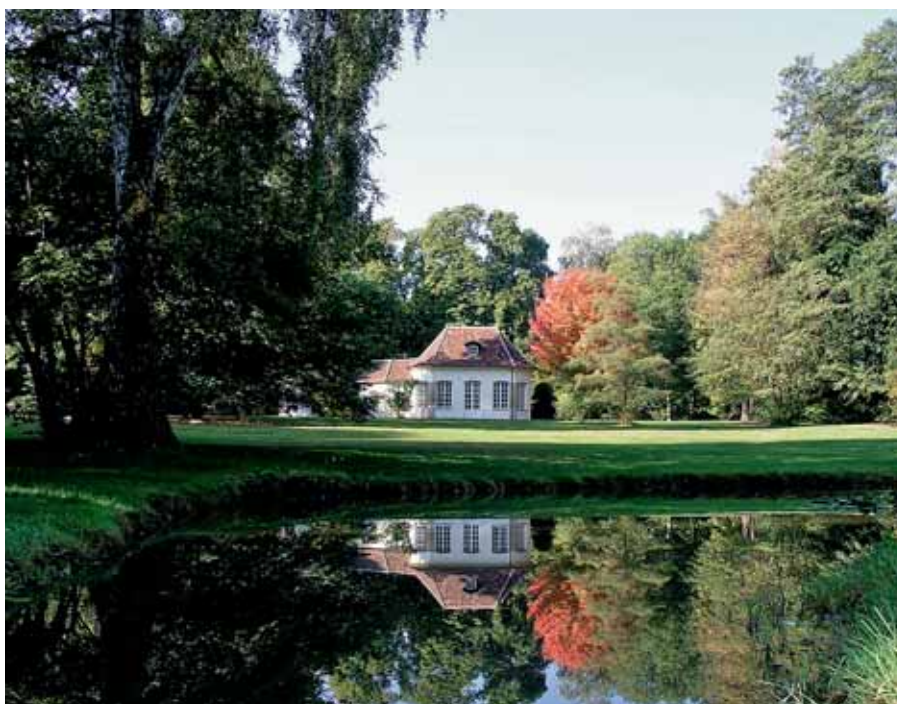
Das Römische Wirtshaus ist eines der letzten Gebäude des Gartens, das bis heute erhalten ist. Unter anderem wohnte hier 1834 Eduard Mörike.
