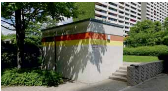
Hier wird der neue Aufzug sein: Zugangsgebäude zur Tiefgarage zwischen Gebäude B und dem ökumenischen Gemeindezentrum.
