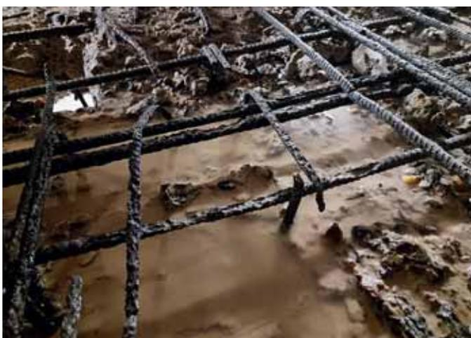
*Bild 4: Umfangreiche Bewehrungsschäden in der Zwischendecke. Stellenweise ist nicht nur die obere Bewehrungslage betroffen, sondern auch die darunterliegende zweite Lage, die maßgeblich für die Tragfähigkeit der Decke erforderlich ist. Derartig starke Schäden waren in den bisher instandgesetzten Einfahrten nicht vorhanden. Das tatsächliche Ausmaß der Schäden ist aber erst im Zuge einer Instandsetzung sichtbar, wenn die Bewehrung freigelegt ist.*
