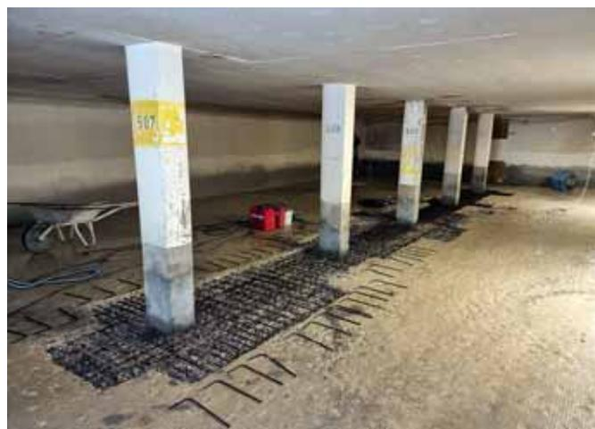
*Bild 5: Abtrag des chloridverseuchten Betons an der Oberseite der Zwischendecke mit einem Teil der vorbereiteten Ergänzungsbe- wehrung.*
