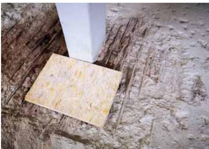
*Bild 2: Feststellung erster größerer Schäden an der Bewehrung der Zwischendecke.*
