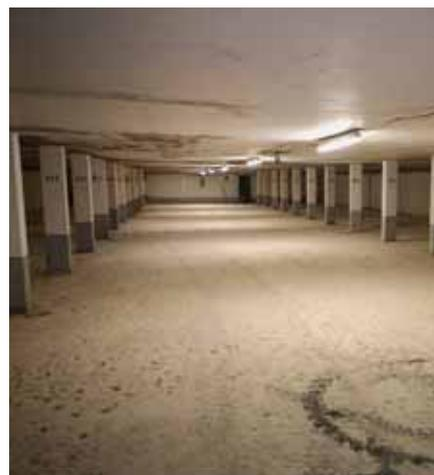
*Bild 1: Oberdeck nach dem Abtrag des alten Estrichs.*
