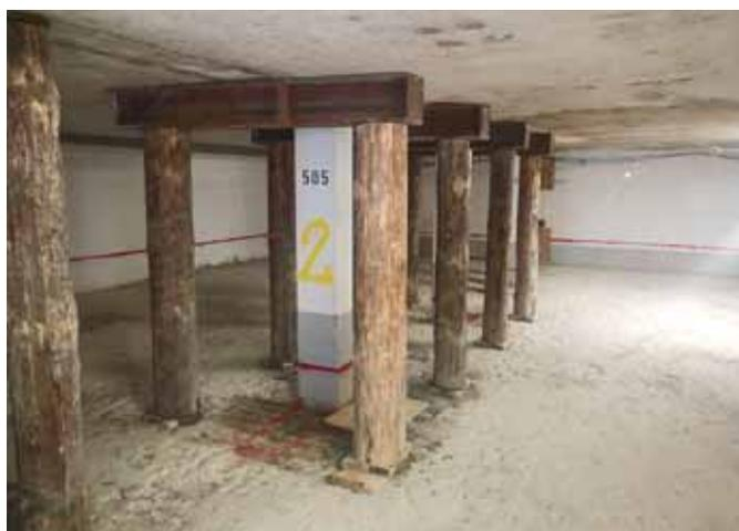
*Bild 3: Zusätzlich erforderliche, verstärkte Hilfsabstützung mit Stahlträgern im Oberdeck.*
