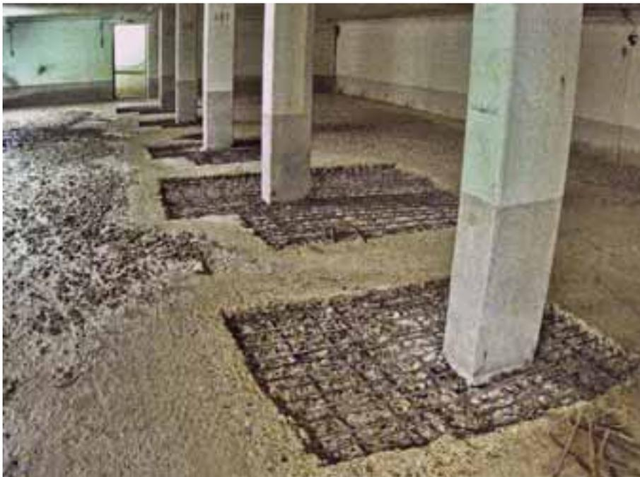
Bild 1: Die geöffneten Armierungen rund um die Stützsäulen.
