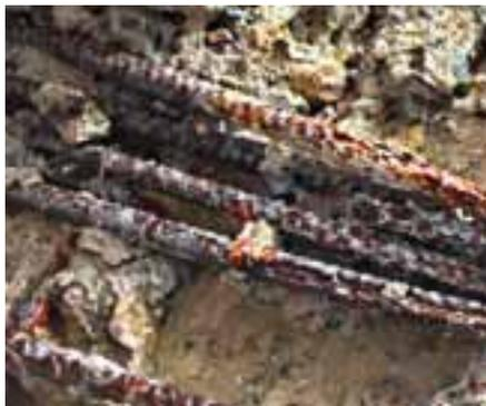
Bild 2: Die Korrosionsschäden an den Armierungsstäben.
