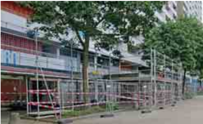
Die Baustelle wird eingerichtet und gesichert
