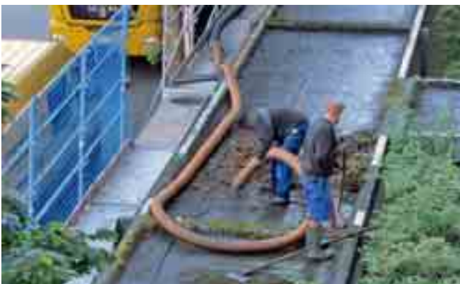
Ende September wurde der Matsch abgesaugt
