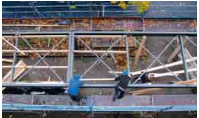
Die Stahlträger wurden gereinigt und gesichert
