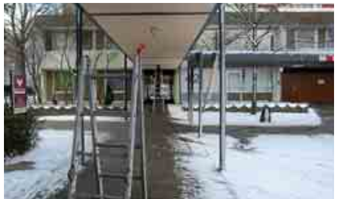
Anfang 2017: Arbeiten an der Beleuchtungsanlage
