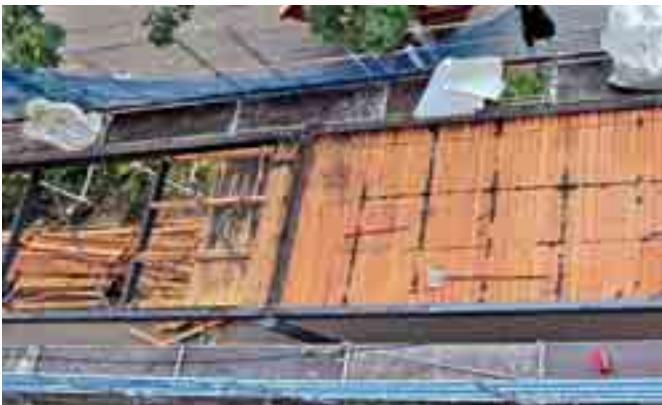
Im Oktober wurden die Pergola-Bretter demontiert ...
