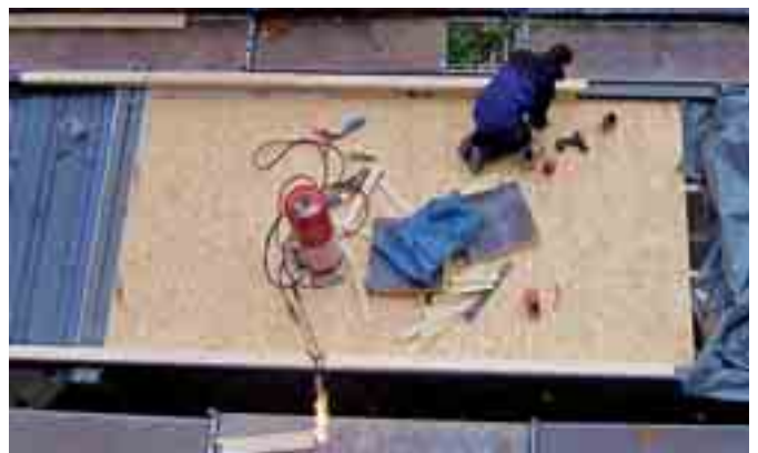
Im November wurden die Platten montiert
