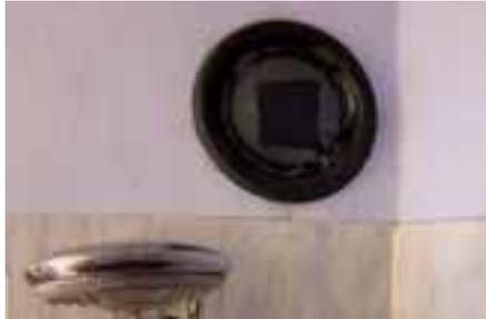
Je nach Wetterlage kann es in den Wohnungen zu trocken werden aber auch zu feucht, wenn nicht genügend belüftet wird. Statt Belüftungsschlitzen in den Fensterrahmen wurden seinerzeit Luftschächte gebaut, um eine stetige Luftzirkulation zu gewährleisten. Wird die Luftzirkulation unterbunden bildet sich fast zwangsläufig Schimmel in der Nähe der Fenster.
